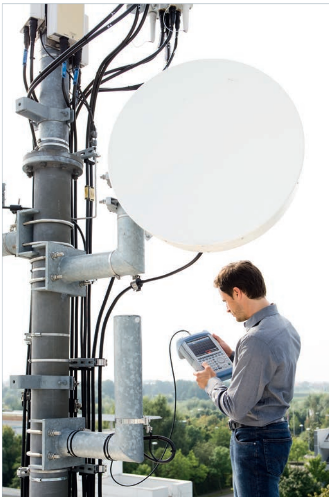
R&S®FSH の使用例（送信基地局の設置や保守点検）
